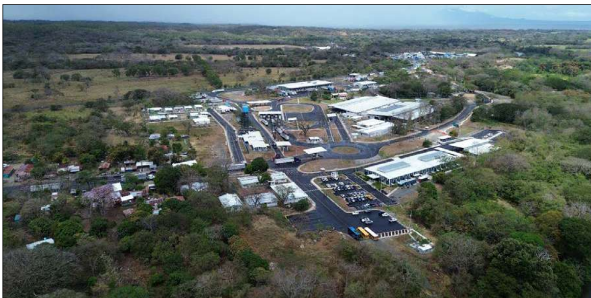
Figura 33. Fotografía general tomada desde el este. Puesto Fronterizo Peñas Blancas (COMEX)
