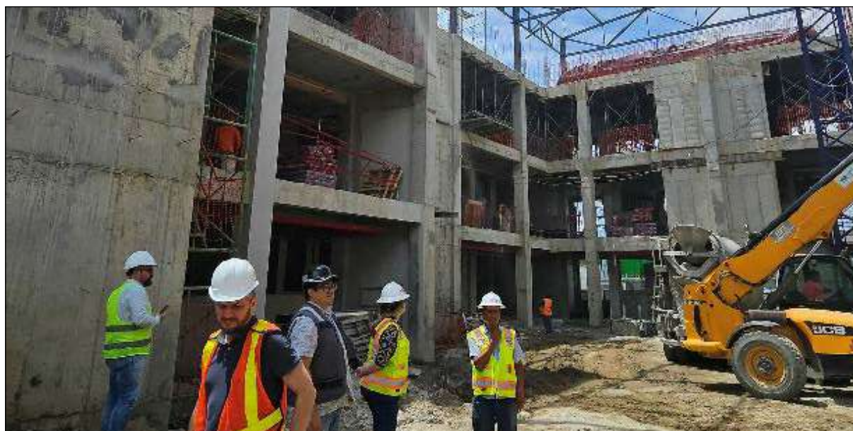
Figura 13. Vista general ala sur. Construcción de la Escuela Barrio Limoncito (MEP)
