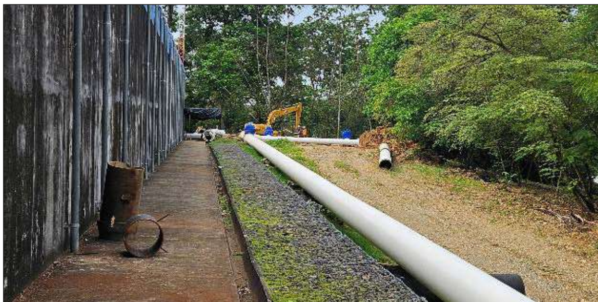
Figura 12. Vista general del bypass. Ampliación y mejoras al Acueducto de Limón, Etapa 2 (AyA)
